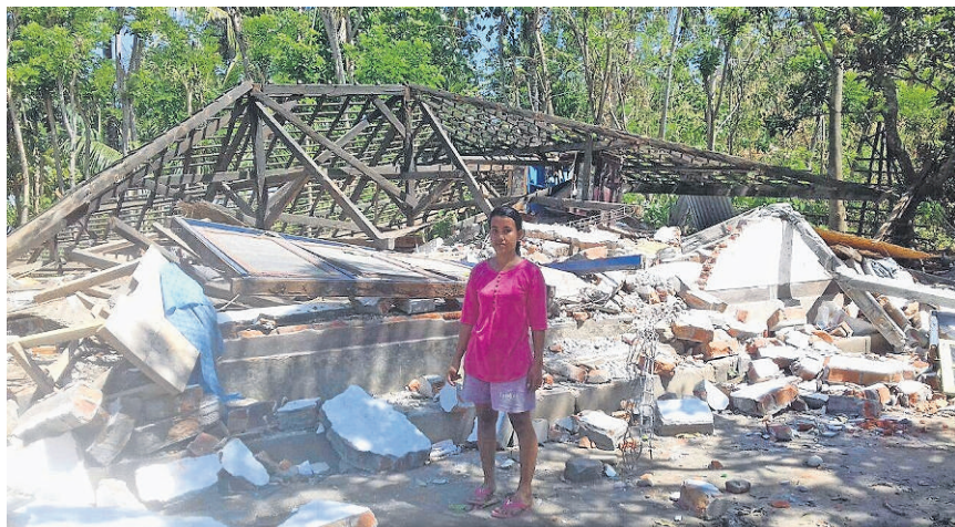
Viele Wohnhäuser sind unbewohnbar.
